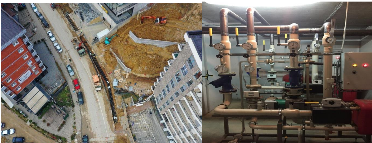
Fig. 7.1 Pamje nga punimet në shtrirjen e rrjetit dhe rehabilitimin e nënstacioneve
