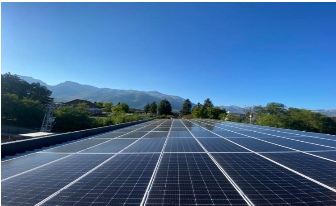
Fig. 3.1 Pamje nga realizimi i një gjeneratori për vet-konsum Sedefi Comerc 70 kW, Vitomiricë, Pejë
