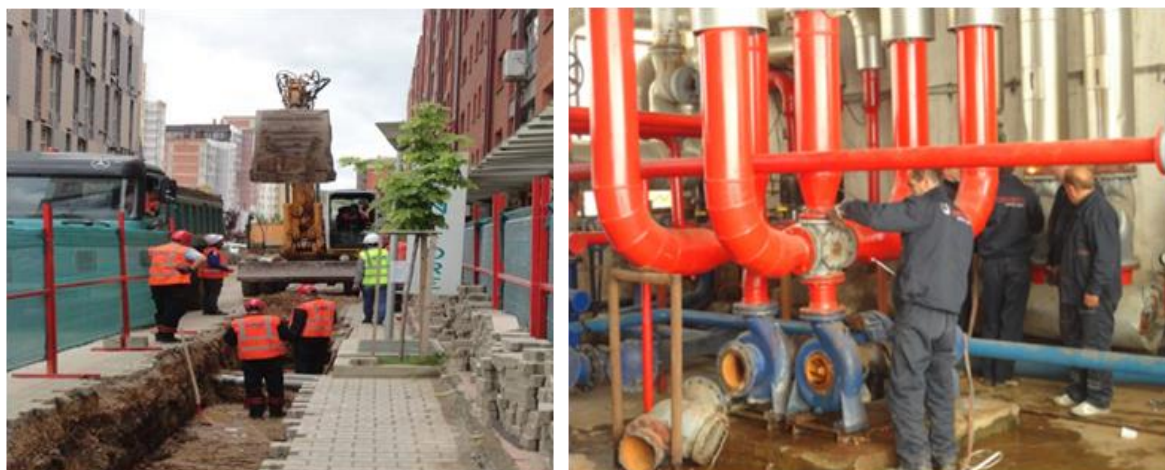
Fig. 7.1 Pamje nga punimet në rehabilitimin e rrjetit dhe nënstacioneve
