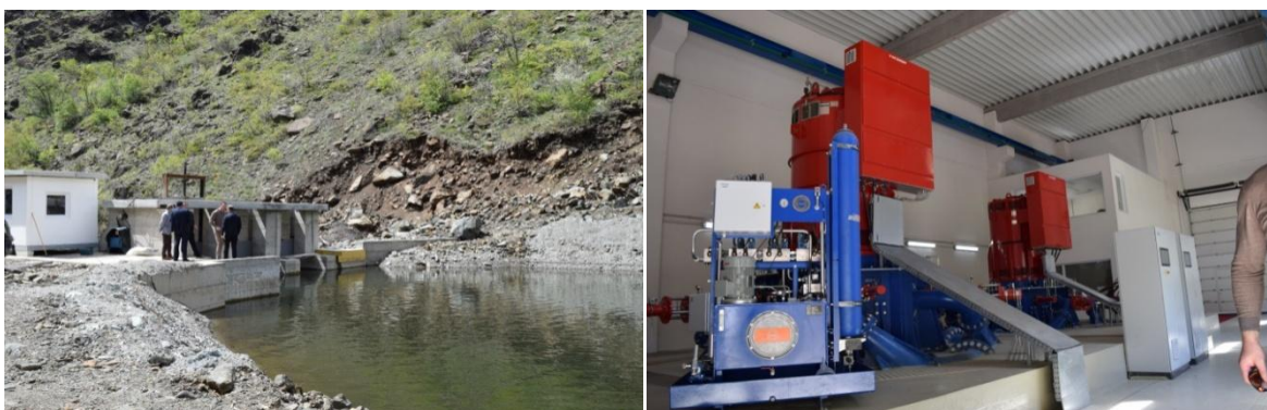
Sl. 2.4 Faza izgradnje HE Albaniku III
