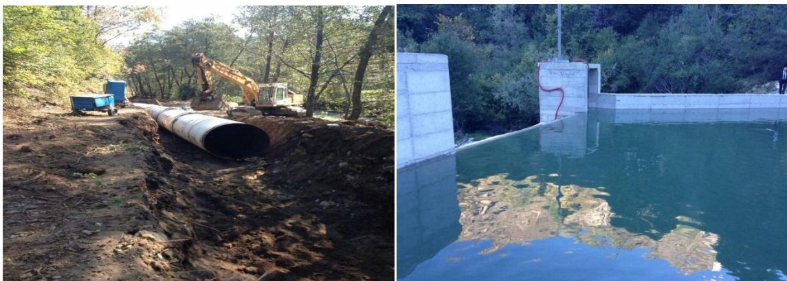
Sl. 2.2 Faza izgradnje HE
