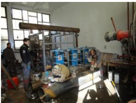
Sl. 6.1 Pogled sa rehabilitacije termičkih podstanica – levo: Radovi na rekonstrukciji podstanice; desno: Podstanica nakon završetka rehabilitacije
